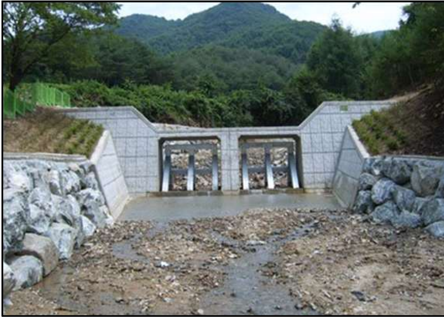
그림 3.48.4 가원개발연구원이 개발한 콘크리트 중공형 사방댐
