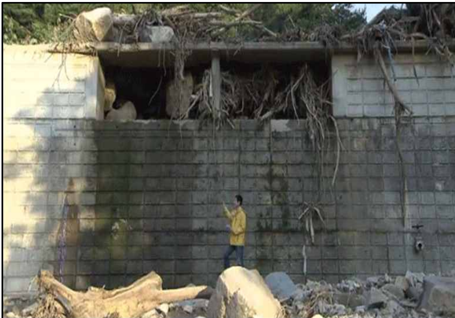
그림 3.48.9 경남 산청군 황매산 계곡에 설치된 5개의 연속 사방댐에 의해 산사태 피해를 막을 수 있었다. 출처 : KBS보도
