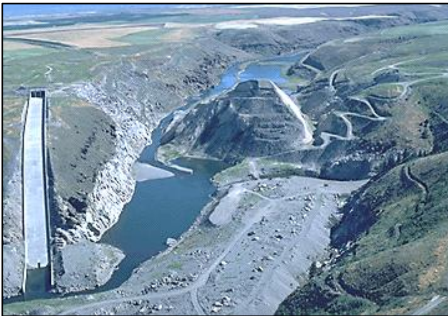
그림 3.77 View of Teton Dam after collapse.
