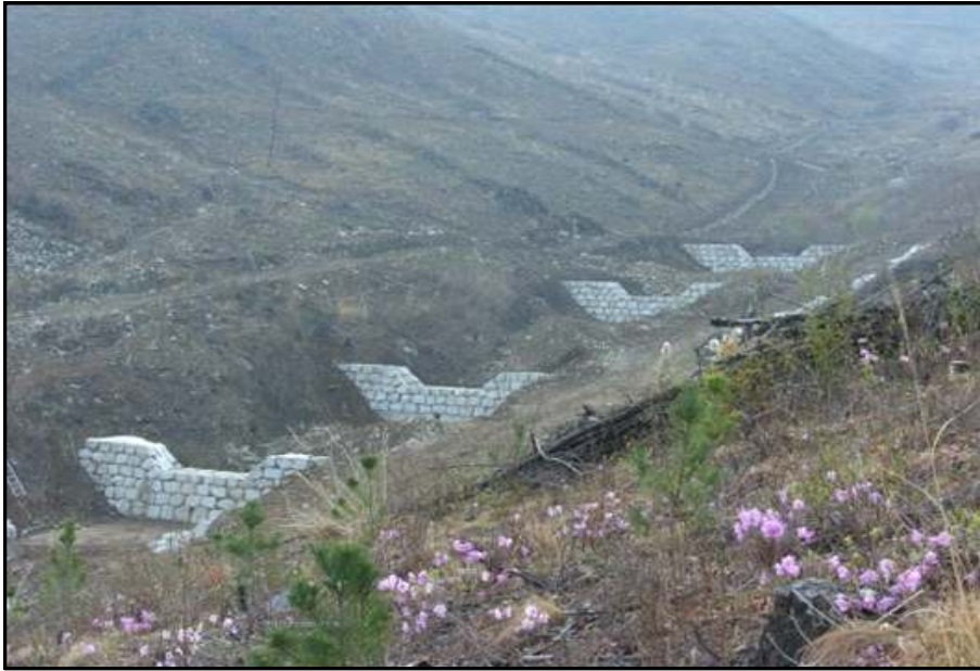
그림 3.48.8 대구시 팔공산 금화계곡의 석축형 다단계 사방댐
