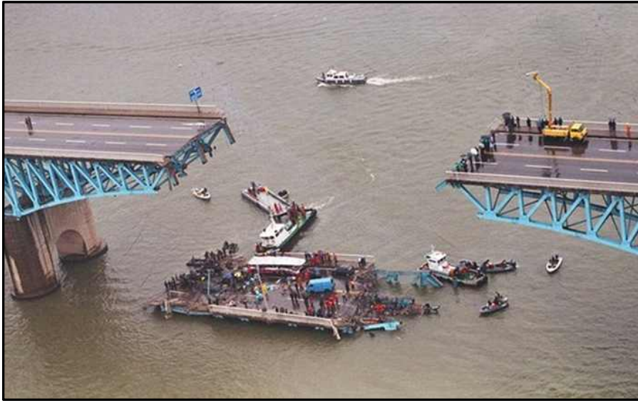
그림 3.84 붕괴된 성수대교(출처 : 성수대교붕괴사건 [聖水大橋崩壞事件, 네이버 백과사전])
